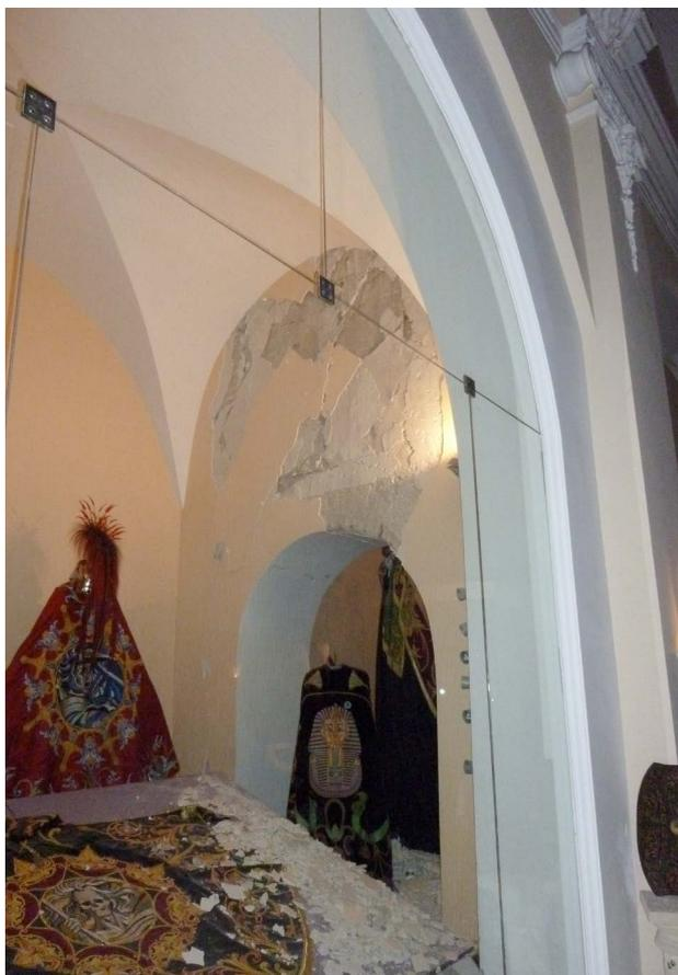
*Detalle de los desperfectos en los muros y arcos de las Capillas laterales.
